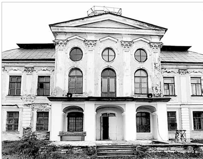
Фрагмент центрального корпуса Большого Меншиковского дворца (северный фасад) 1996 ГМЗ «Петергоф»
