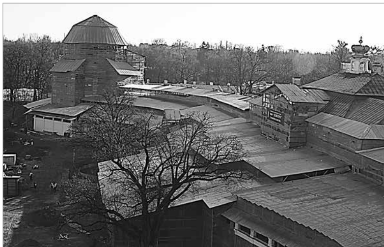
Вид на Большой Меншиковский дворец в период реставрационных работ (северный фасад) 2009 ООО «Деметра»
