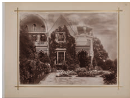
449/16 Коттедж. Фрагмент северной террасы с фонтаном «Нимфа, играющая с дельфином»
