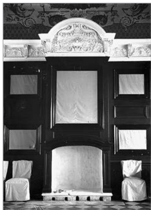
Варжанский В. В. Фрагмент с камином в Центральном зале 1917 ГМЗ «Петергоф»
