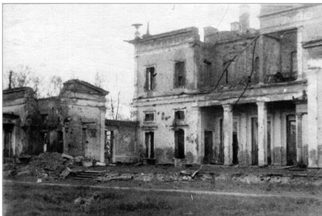
Разрушенный южный фасад дворца и уничтоженный западный портик 1950
