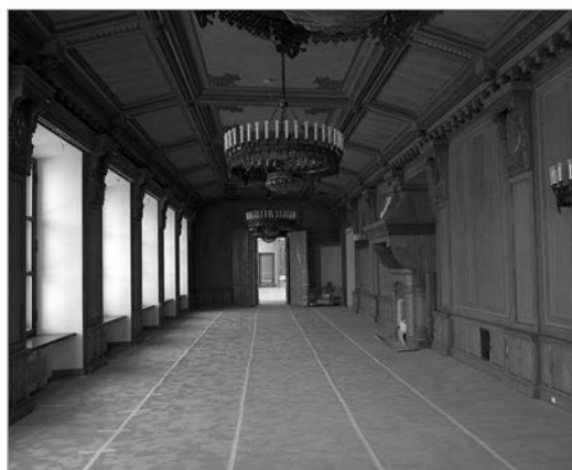
Михайлов Б. А. Гербовый зал Тверского императорского дворца в процессе реставрации 2015
